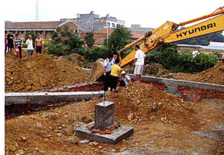
拆除违法建筑
