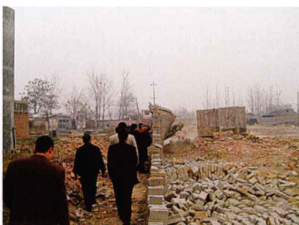
砖瓦窑整治现场
