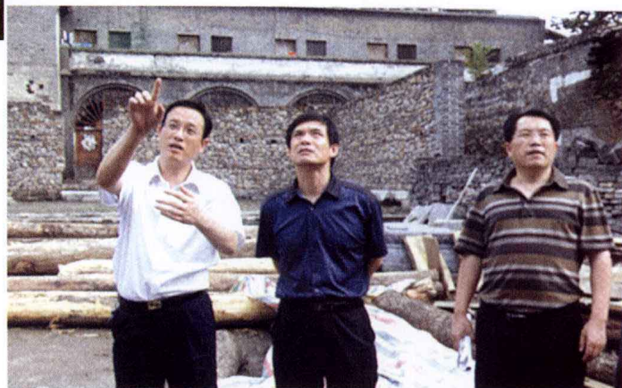
2009年8月19日，市委副书记、常务副市长唐群喜（中）在神垕镇察看老街修缮保护工作施工现场。
