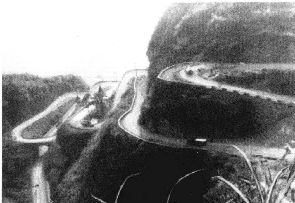
乾城县矮寨坡盘山公路(图2)
