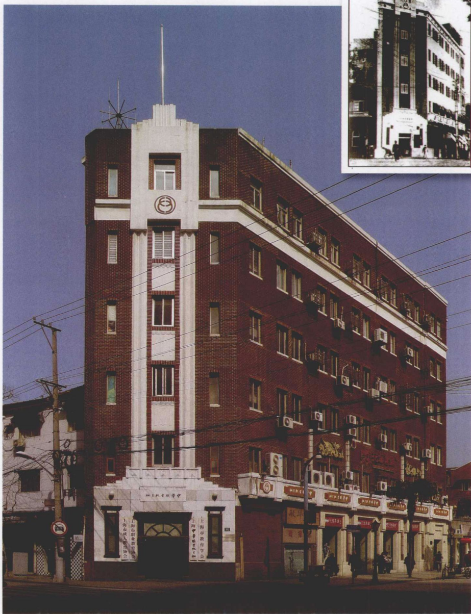
雁荡路80号，中华职教社旧址，1930年落成。上图为原建筑，1982年复社后，上海中华职教社在此办公。为办学所需，加盖6层，下图为加盖后的现状。
