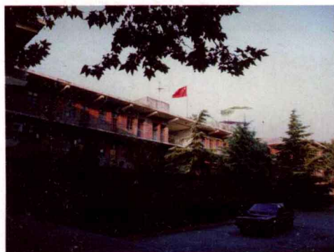
方山煤矿行政办公楼
