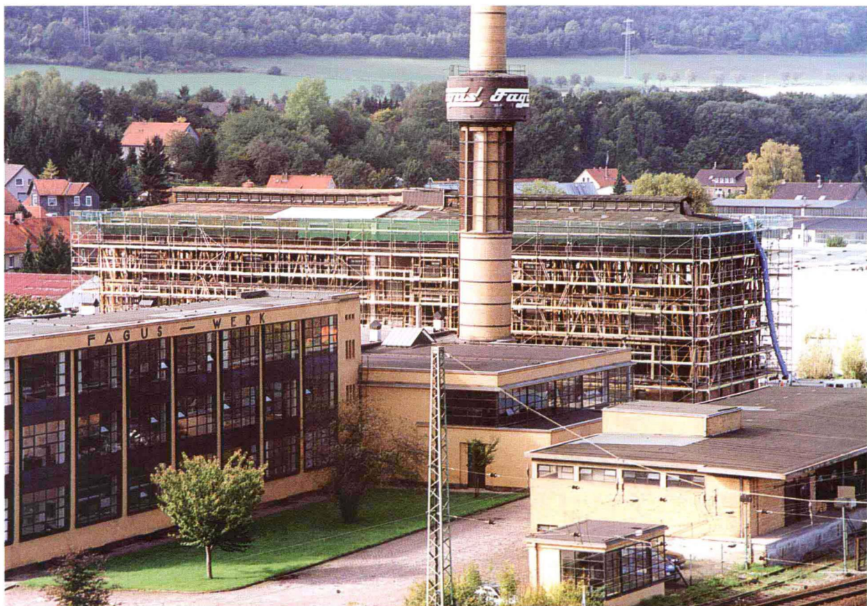
图 6-2 法古斯工厂 (Fagus Factory) 是一座由 10 座建筑物组成的建筑群, 是现代建筑与工业设计发展中的里程碑
