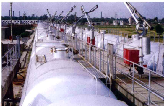
可整列接卸油罐槽车的铁路专用线
