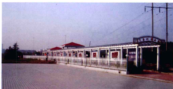
建立在公园内的气象观测站和气象科普画廊
