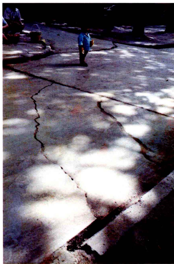
陕重机厂家属院（左）和电磁线厂（右）水泥地面被地裂缝破坏情况
