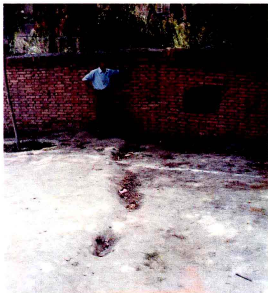
陕重机厂子弟学校东墙，左：内侧地面北升南降；右：外侧道牙断裂南沉
