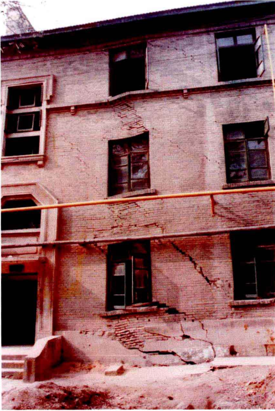
西安秦川厂家属楼被地裂缝破坏情况（左：东墙，右：西墙）
