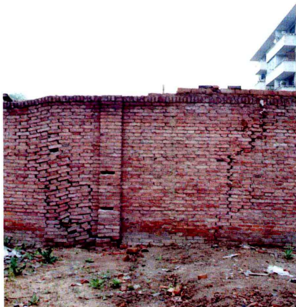
陕西省委党校西墙因北盘隆起而破裂（镜向西）
