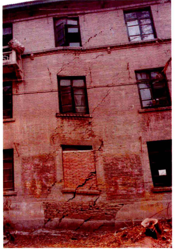
西安秦川厂家属楼被地裂缝破坏情况（左：东墙，右：西墙）
