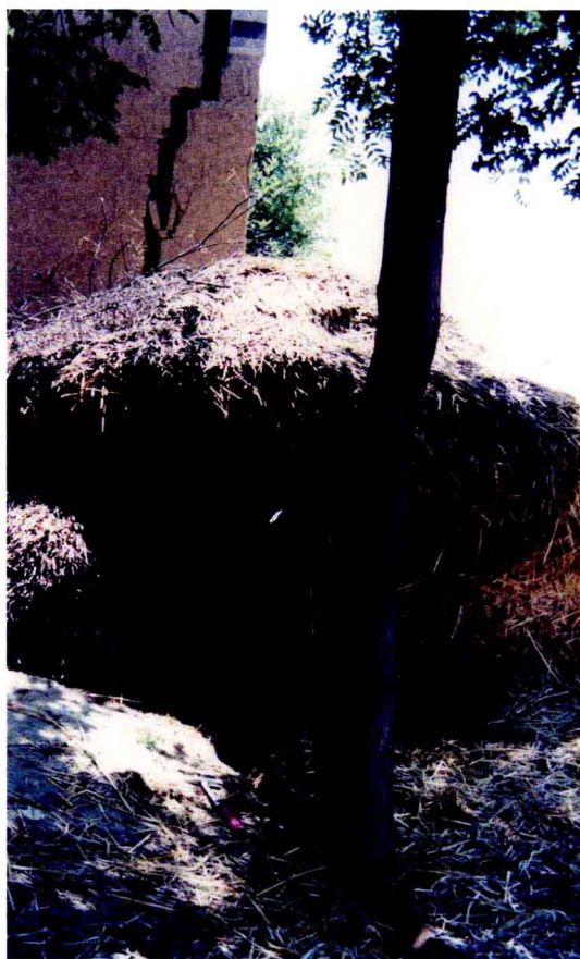
房屋及树木被地裂缝破坏情况（左：西安铁炉庙，右：泾阳）
