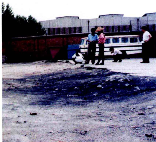
矿院（现西安科技大学）实验工厂院内 地裂缝南盘下降，水泥地面完全破坏
