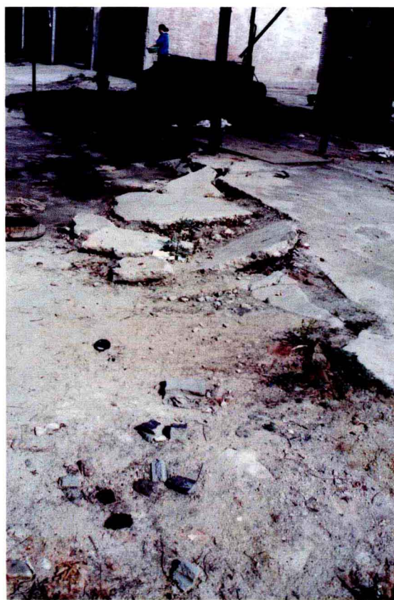
陕重机厂家属院（左）和电磁线厂（右）水泥地面被地裂缝破坏情况
