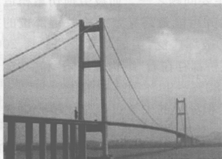
图 1.2 润扬大桥南汊悬索桥
