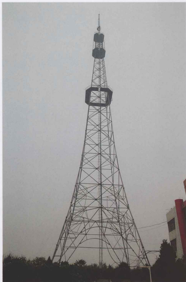
上蔡县电视台电视转播塔
