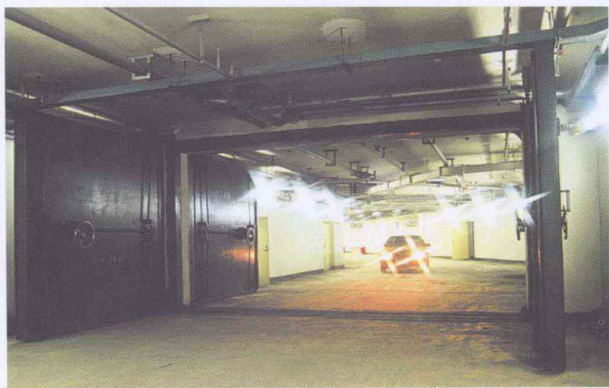
◎结合城市建设修建 的人防工程
