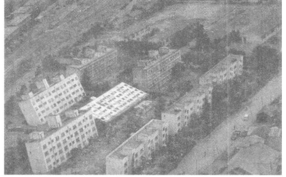
图 9 日本新潟地震中的地基液化现象
