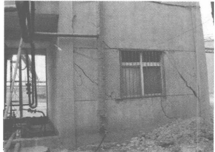
图 5 地基沉降导致墙体开裂
