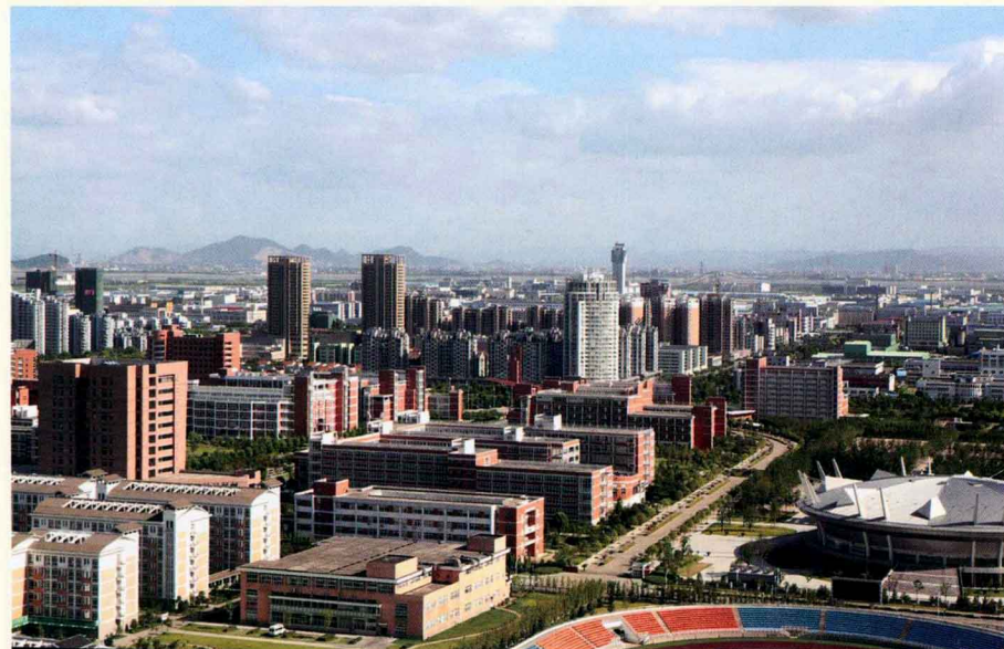
杭州下沙高教园区近貌
