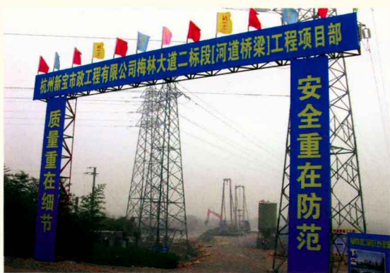
2007年10月27日,开发区跨江发展新区块——江东区块开工建设
