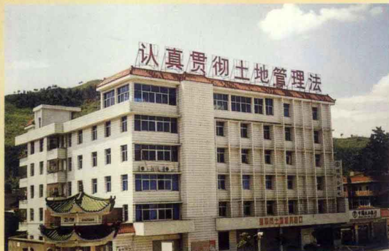
▲漳平市土地管理局办公大楼
