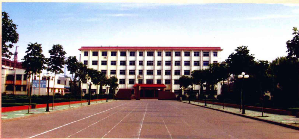
洛阳农科院北院科研办公楼
