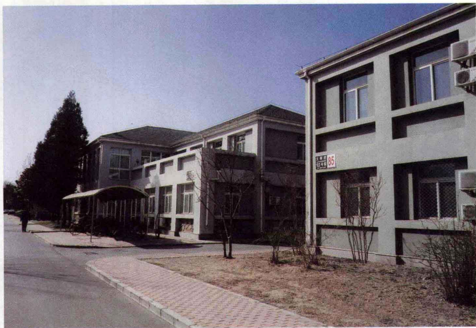
改造后的 81~86 号楼
