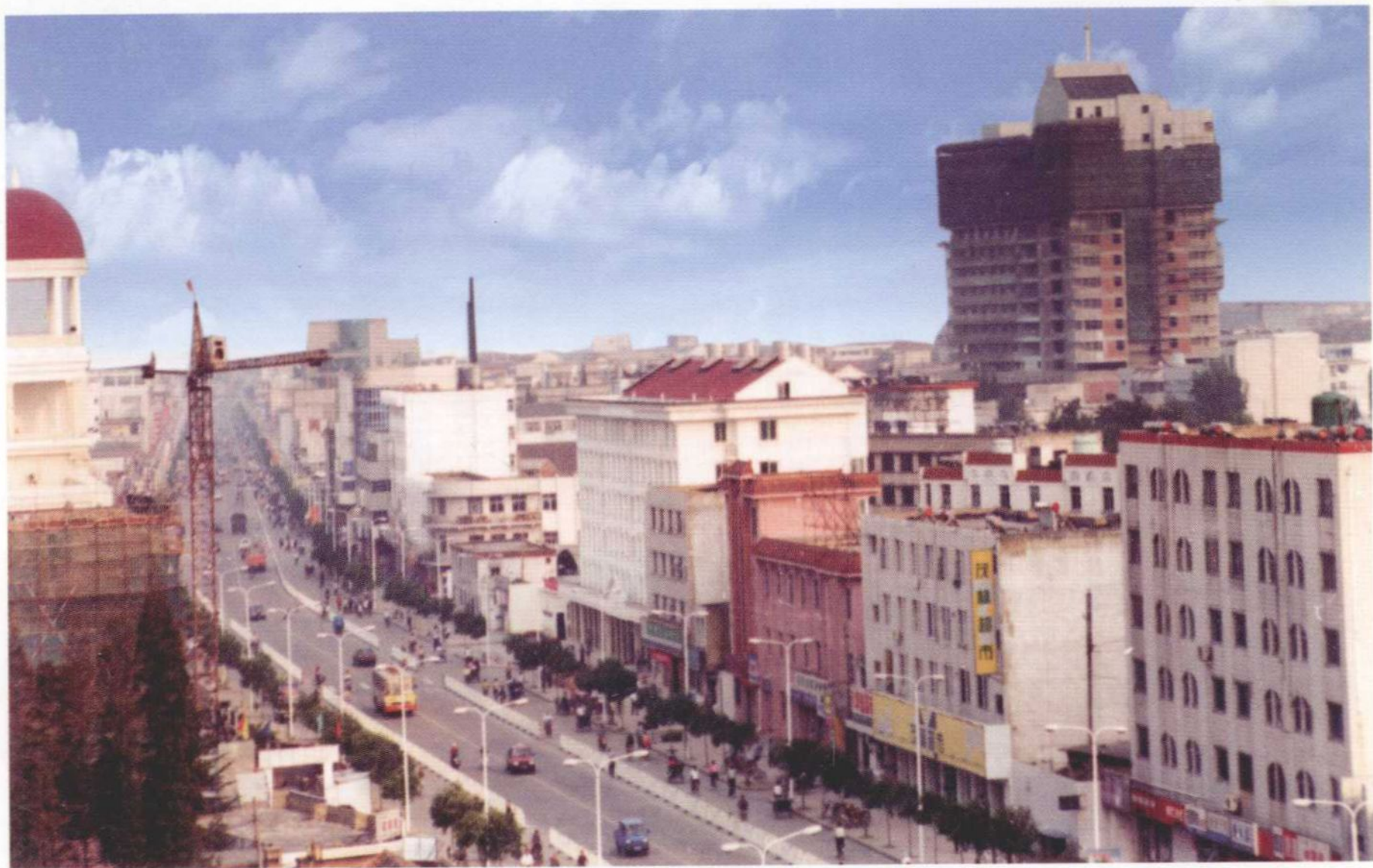
建设中的淮阴县城
