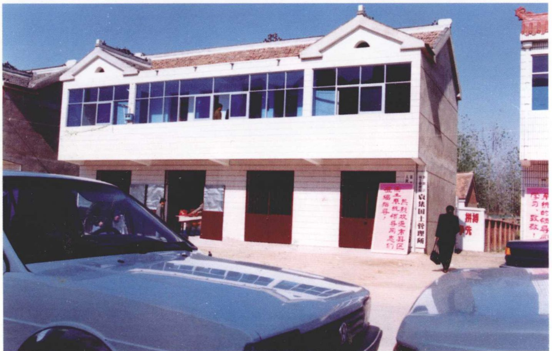
袁集国土所办公楼
