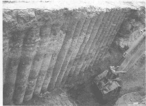
图 1-6 混凝土重力式围护结构实体照片
