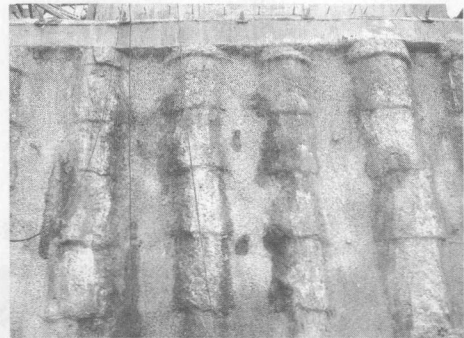
图 1-4 悬臂式支护照片
