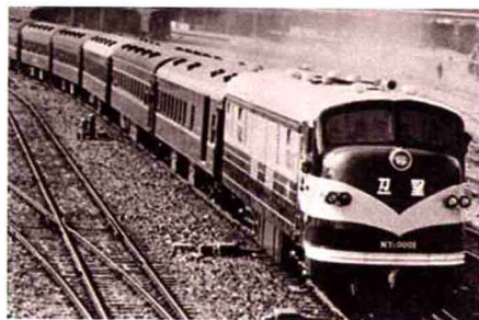
图 1.16 “卫星号”液力传动内燃机车
