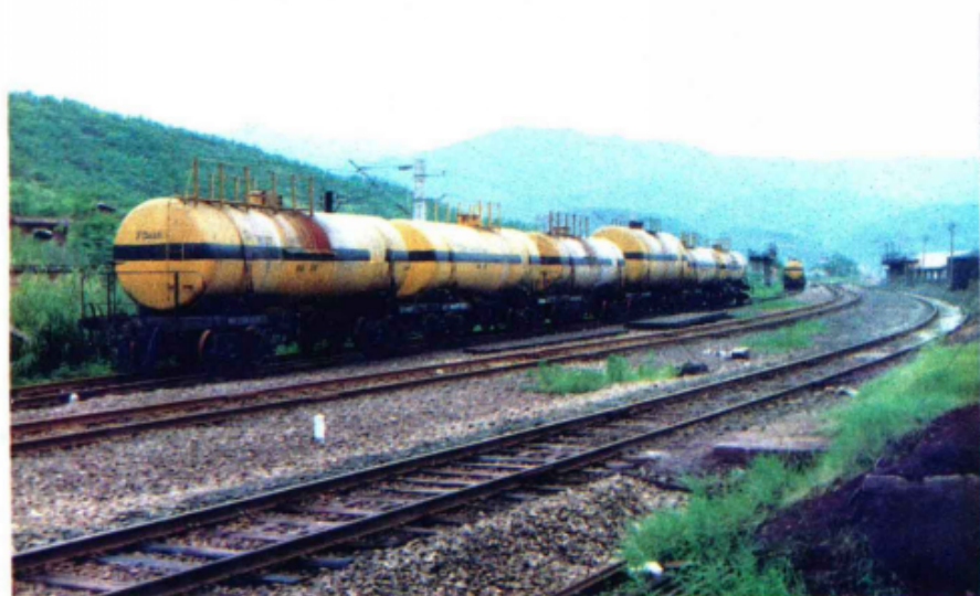
漳平硫酸 厂铁路专用线 和自备硫酸罐 车
