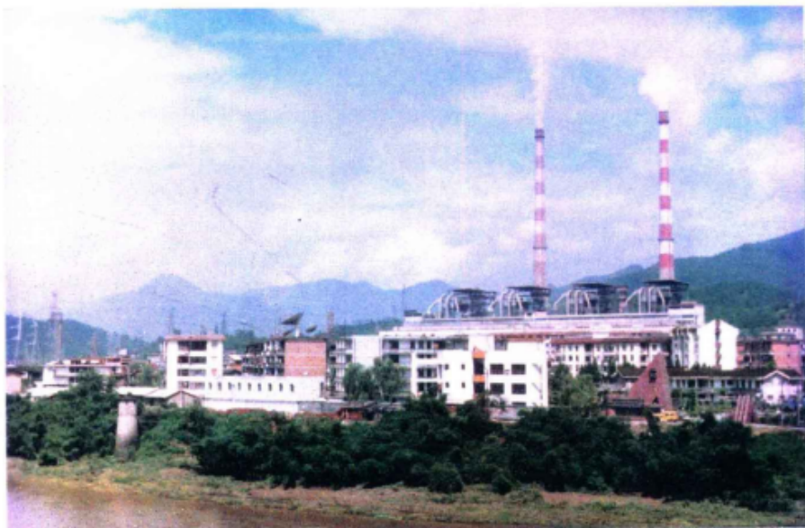
总装机容量6万千瓦的漳平电厂
