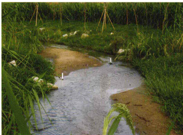
照片 1-5 利于生物生存的浅滩和深潭交替的近自然河流 (2005 年 5 月摄影, 深圳市)
