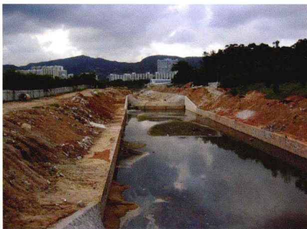
照片 1-6 河道的混凝土化导致生物生境的丧失 (2005 年 5 月摄影, 深圳市)
