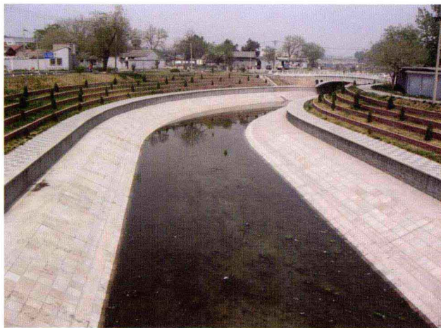
照片 1-4 直线化的混凝土河道 (2004 年 4 月摄影, 北京市)
