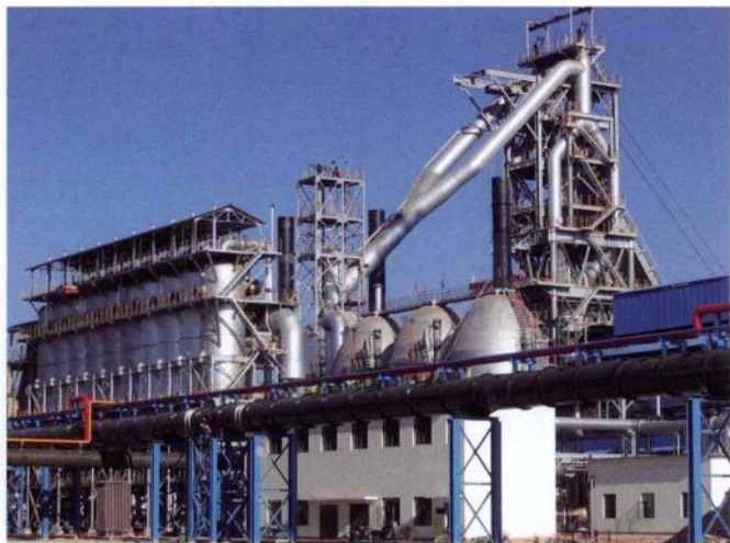
中钢石家庄设计院设计的某钢铁公司炼铁车间之一角
