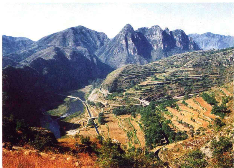
盘石头水库坝址
