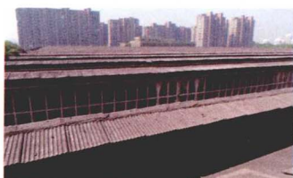
锯齿形厂房屋顶采光的一面
