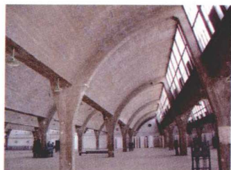
锯齿形屋顶的内景
