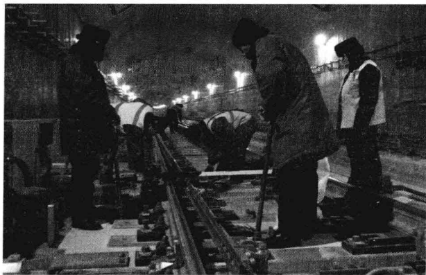
图1-6 无砟道岔改道作业
