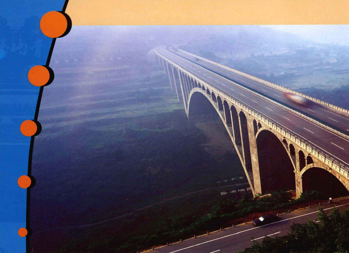
晋焦高速公路丹河特大桥
