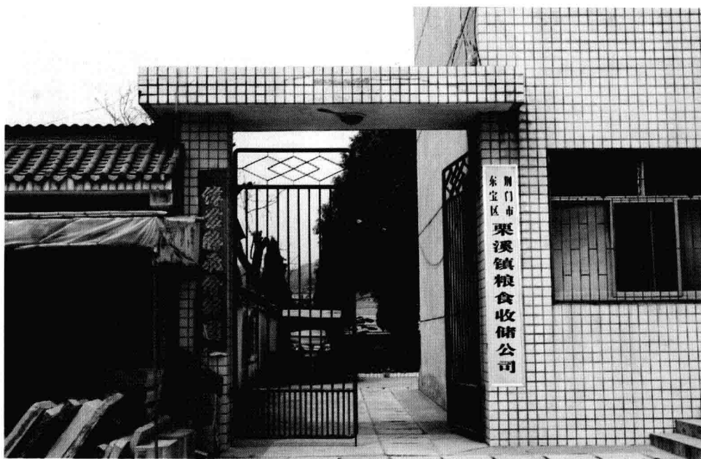
东宝区栗溪镇粮食收储公司办公楼
