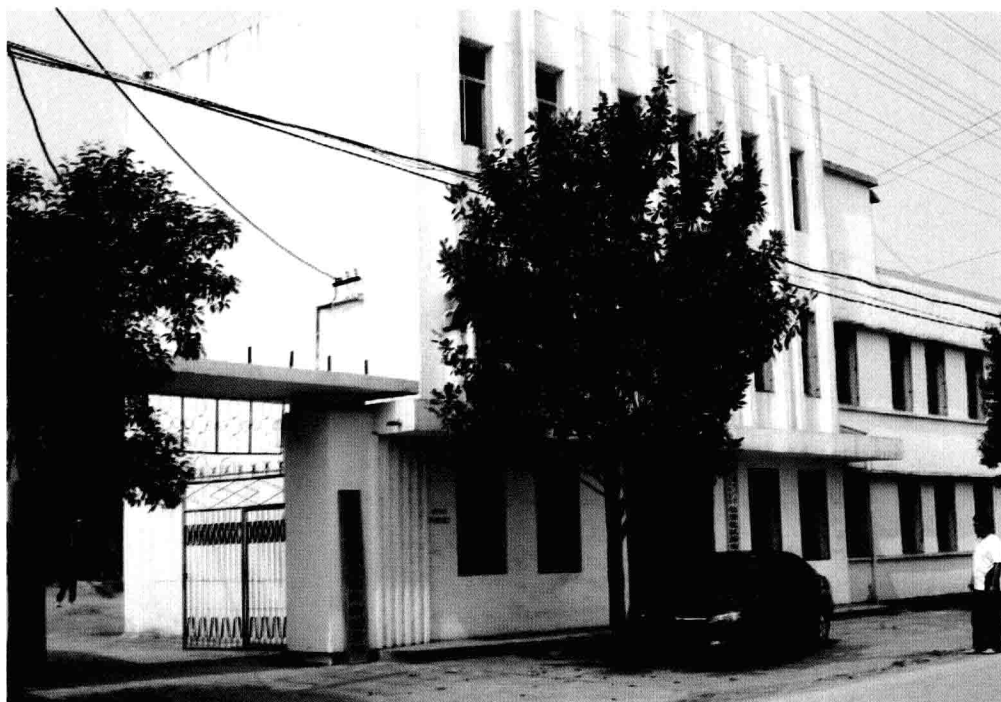
东宝区仙居粮食收储公司办公楼
