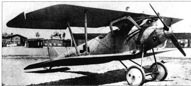
普法尔茨战斗机的上机翼与机身之间的空隙被压缩至最小，使飞行员有了全方位的良好视野。
