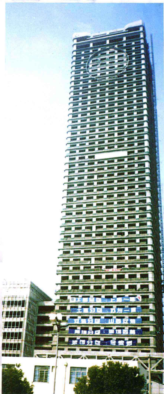
深圳市中南富海 实业发展总公司建设 装修的51层的苏州商 品交易所主楼
