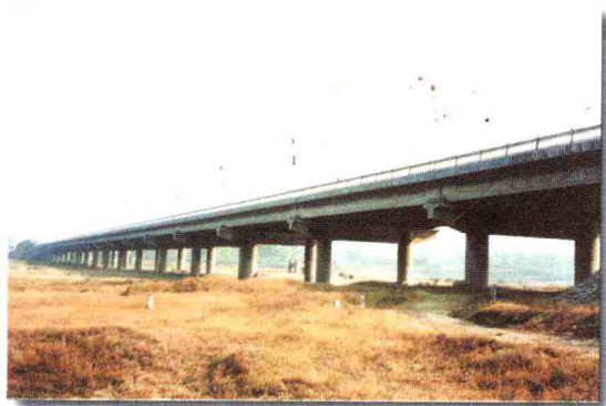
中南富海实业有限公司所 属的路桥分公司施工承建的许 平南高速公路的清河大桥
