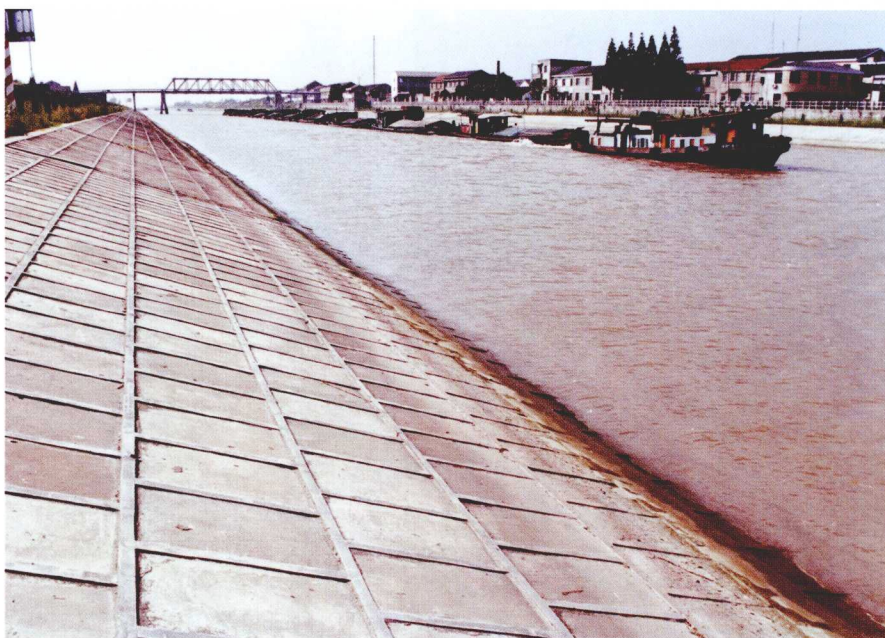
苏南运河整治后整齐顺直的斜坡式护岸。
