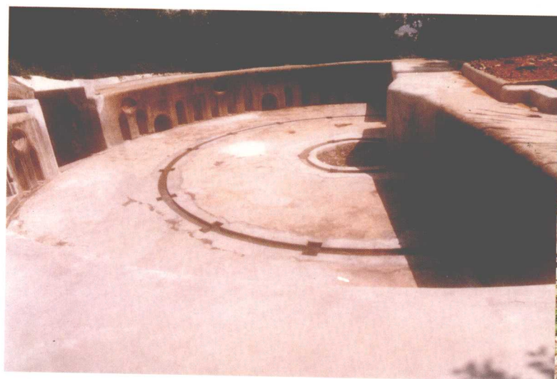
清 大角山振定炮台
