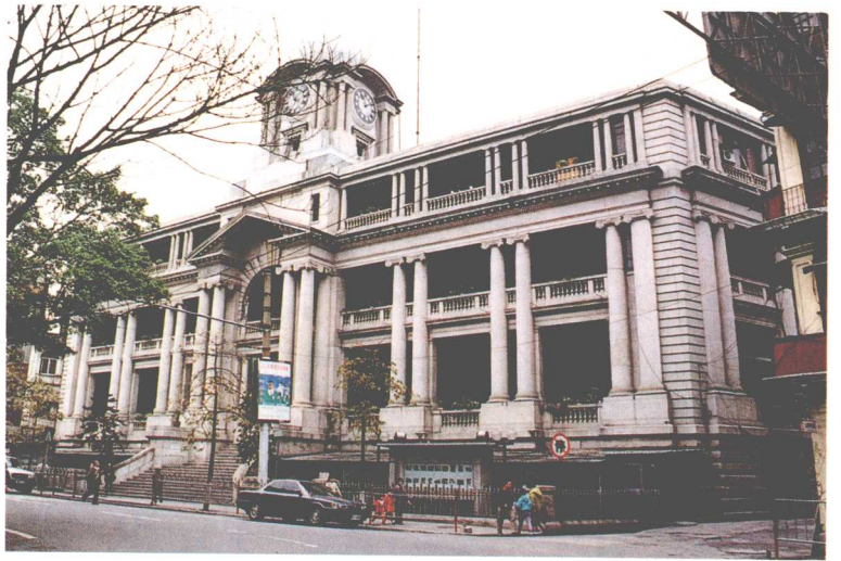
民国 粤海关大楼
