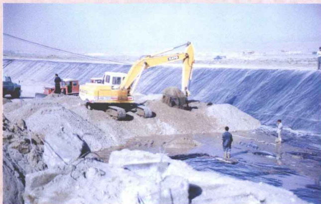
◀塔北二千渠施工现场。 (1997年)
