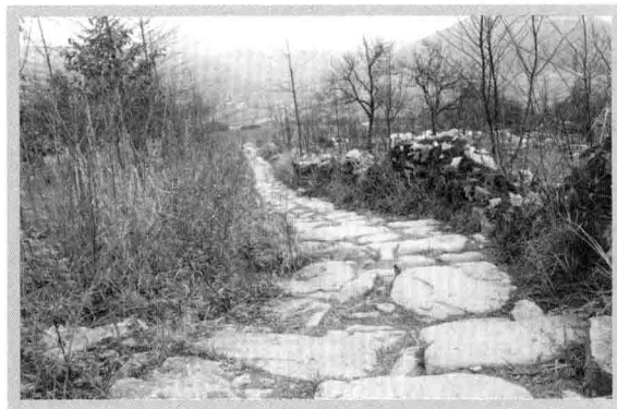
◆ 川黔古道息烽段遗址大风垭段局部二
