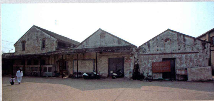
恒源畅厂老厂房
