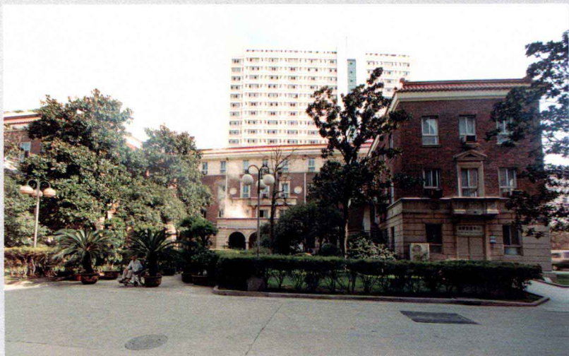
武进医院病房大楼旧址
