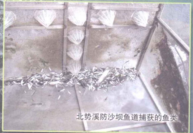
北势溪防沙坝
