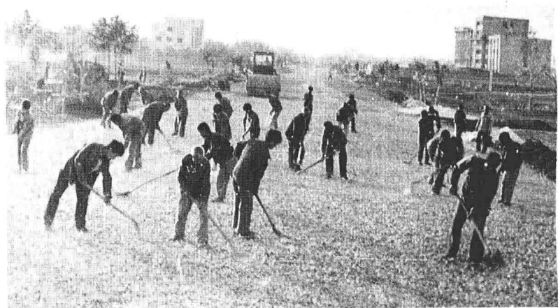
中岳大街东段施工
