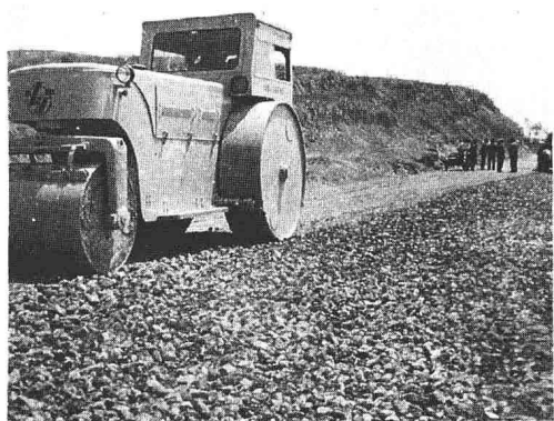
新登、告公路施工
