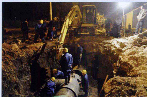
● 市政工程人员应急抢修燃气管道
