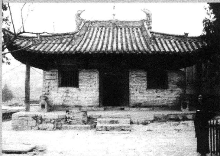
天台庵，唐朝天祐四年（907 年）始建。遗存位于晋东南平顺县王曲村。是国内目前仅存的四座唐代木结构建筑之一，庵院东傍山峪，西临漳水，远山连水，景色幽雅。
