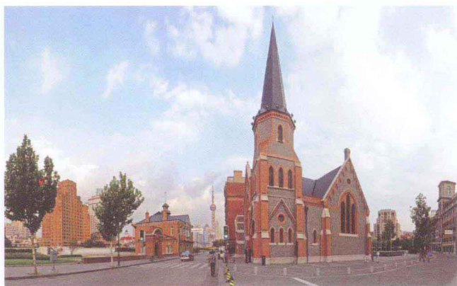
苏州河畔建造于19世纪中期的划船总会旧址（教堂左侧为留存 的建筑）和建成于1886年的新天安堂
