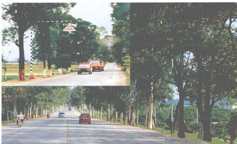
1992 年改造前后的 205 国道蕉岭华侨场段（蕉岭县方志办提供 魏小良摄）
