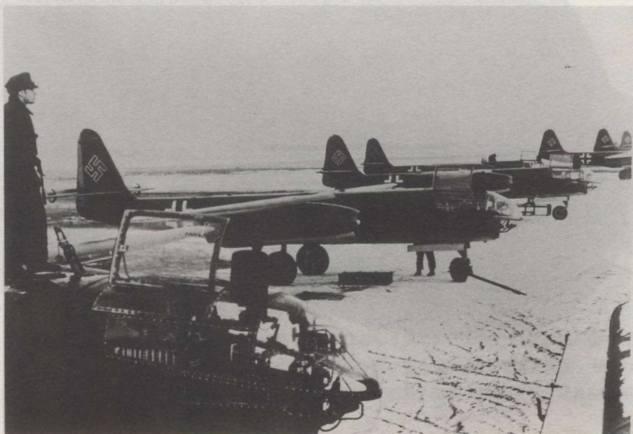
上图：Ar 234B-2飞机的功能远远超过了其前一代机型Ar 234B-1飞机的功能，可以执行轰炸、导航或侦察任务。该机型在发动机短舱的外侧装备了Rauchgerate（烟设备）公司的起飞助推火箭。
