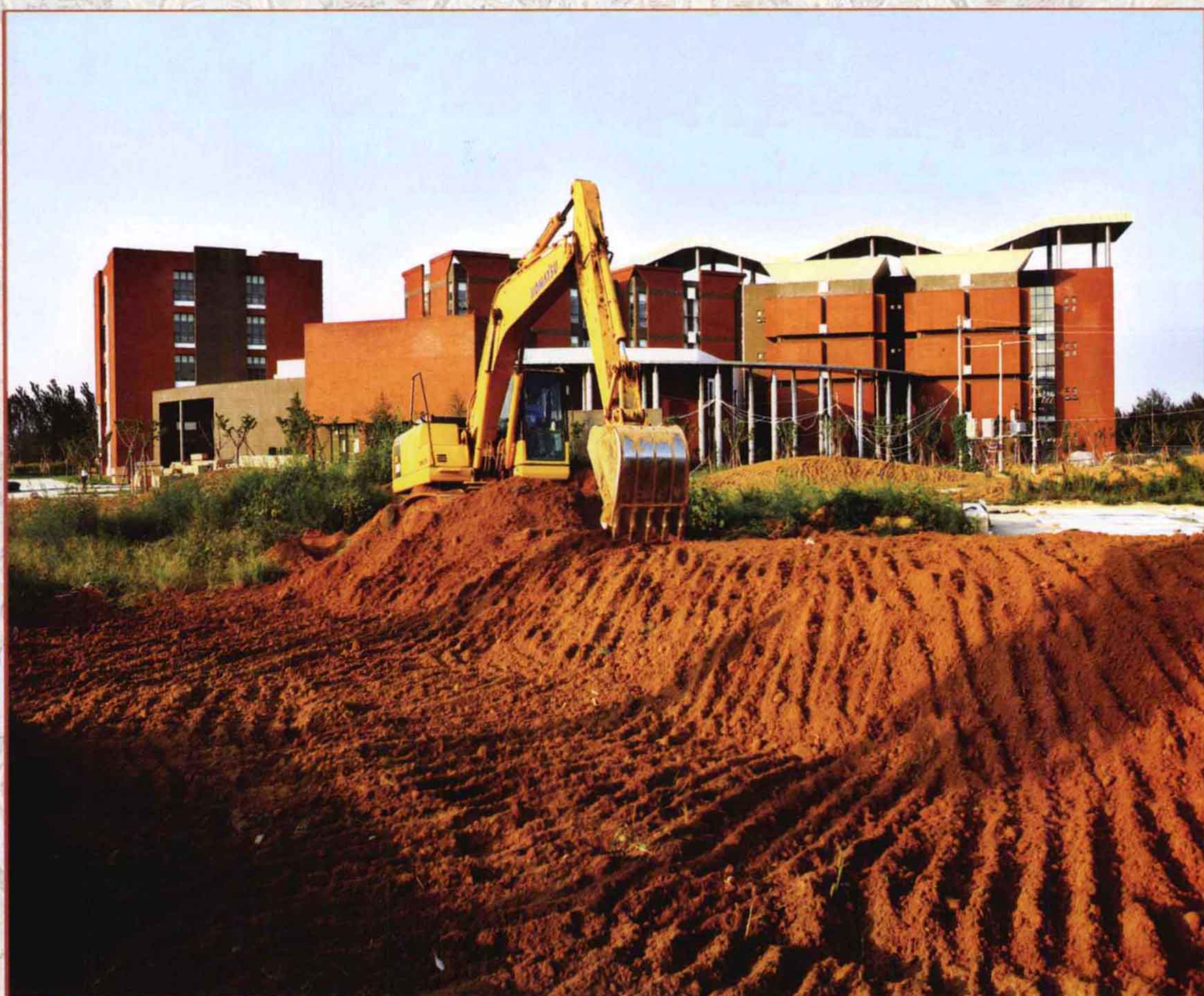
2007年正在建设中的永城市档案馆(左上)、永城市老干部活动中心(右上)、永城市群艺馆(左下)。中图为施工现场
