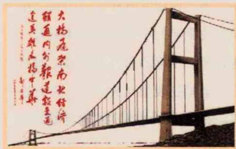
天堑变通途——江阴长江大桥
