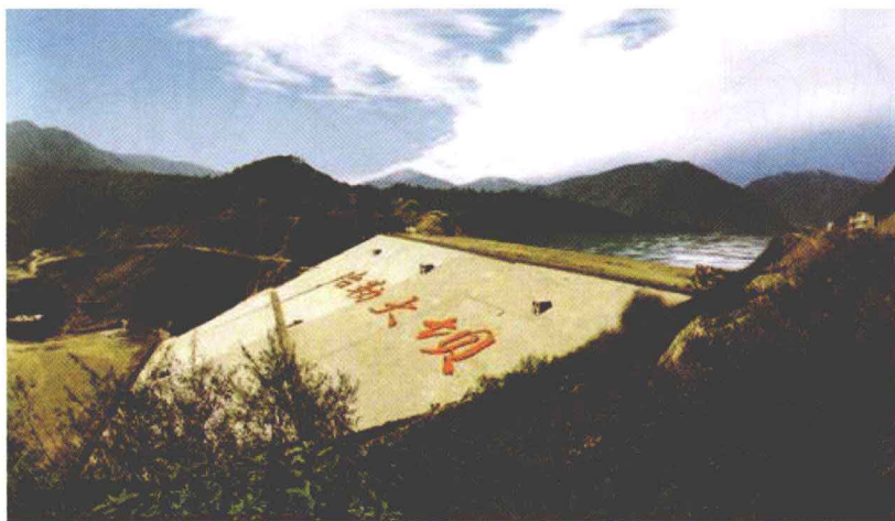
图 1-4 冶勒水电站碾压沥青混凝土心墙堆石坝
