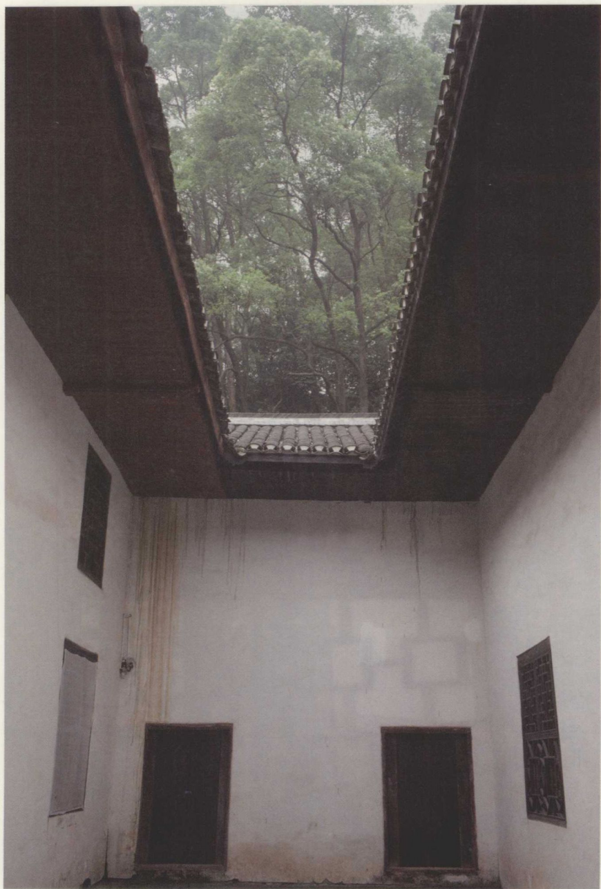
富厚堂之天井
