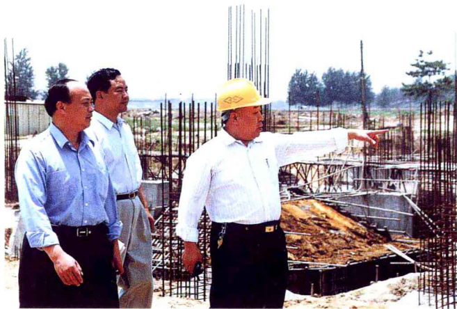
周口发电有限责任公司党委书记、董事长侯德智及其它厂领导在三期工程工地上
