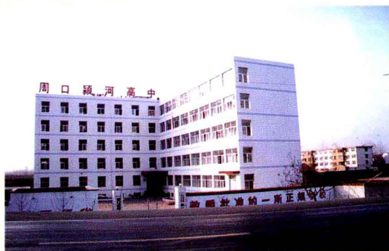
社会力量办学——颍河高中教学大楼
