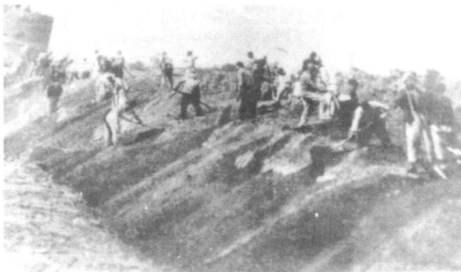
日寇强征于西万多民工在登封城西修飞机场 图为民工在日寇监督下挖土填沟
