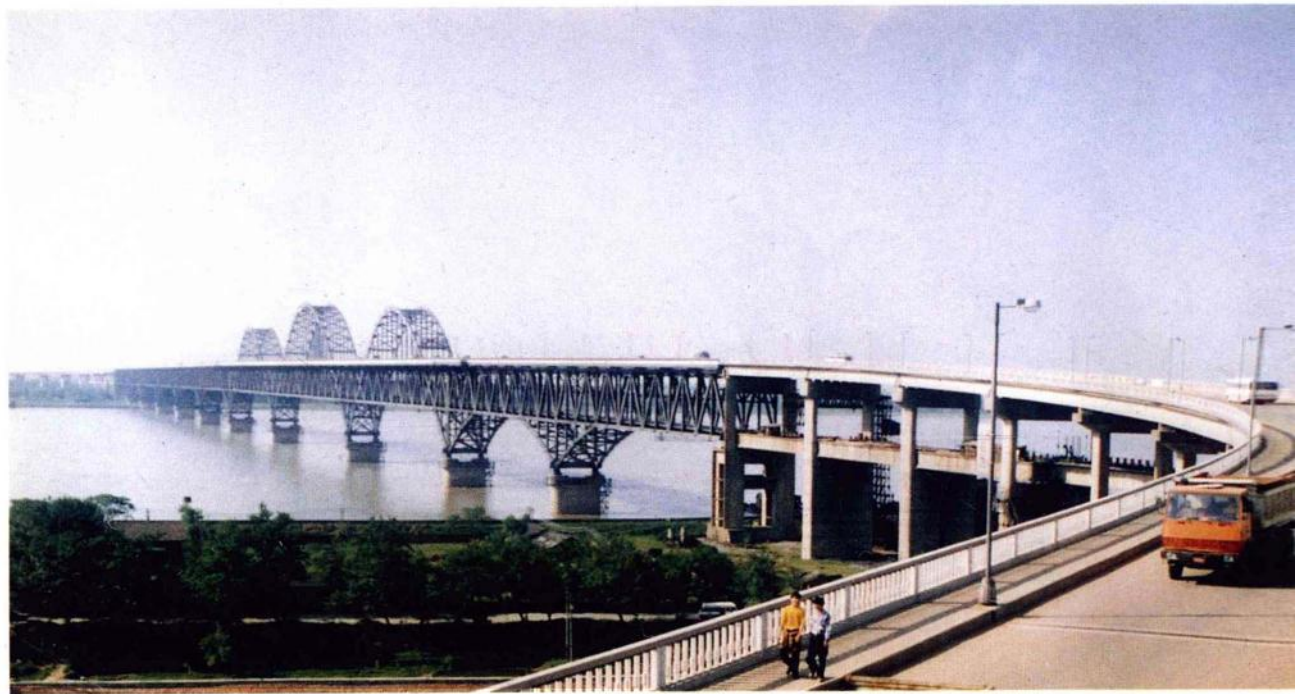
创造多项国内外建桥先进技术的九江长江大桥
