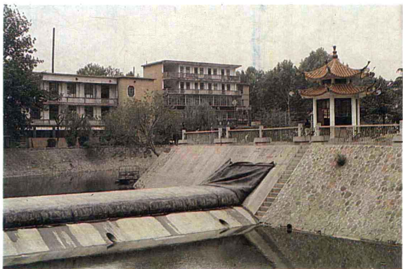
中原路橡胶坝
