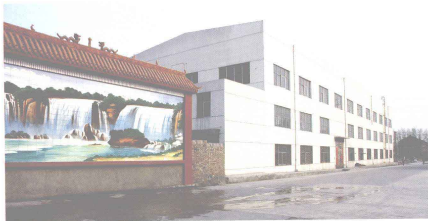
← 综采设备修理车间
