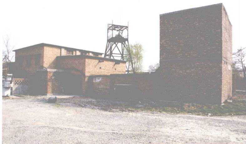
罗庄抽风机房
