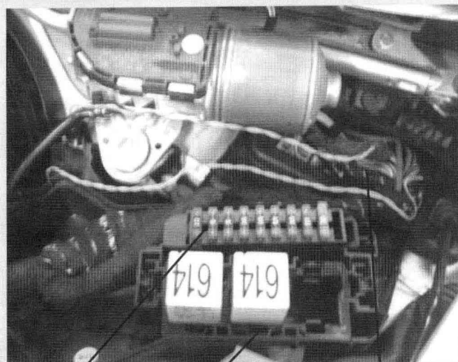
排水槽电控箱熔丝座 排水槽电控箱继电器座 排水槽电控箱接线板 排水槽左侧电控箱的布置
